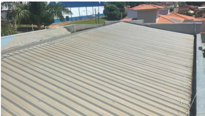
TELHADO A SER REMOVIDO E REINSTALADO PARA MANUTENÇÃO DAS CALHAS
